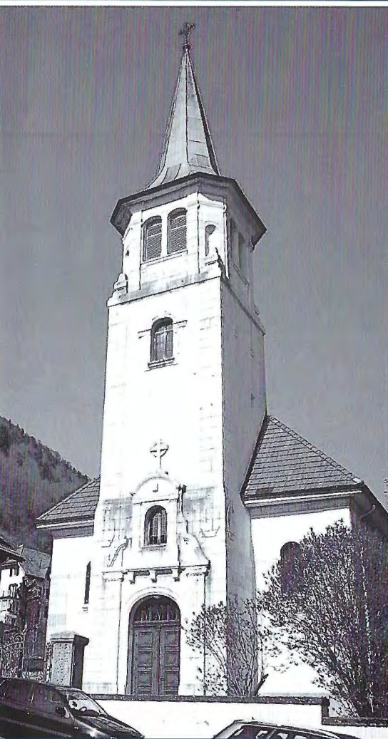
Sanierung des Glockenturms der Paulus-Kirche von Saint- Imier
