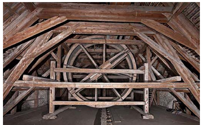
Tretwerk vom Kirchenbau im Dachstock Foto: Schenker, Denkmalpflege
